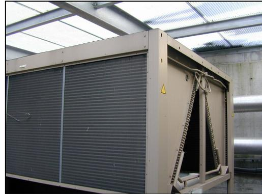
Si le condenseur est placé sur une toiture couverte de roofing noir, répandre du gravier blanc sur la toiture pour empêcher une surchauffe locale de l'air qui peut atteindre plusieurs degrés en période d'ensoleillement. De même, installer un système d'ombrage du condenseur évitera une surchauffe en période d'ensoleillement.
