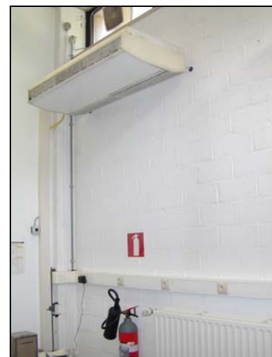
Exemple de deux unités terminales avec des régulations indépendantes : le radiateur et le split
