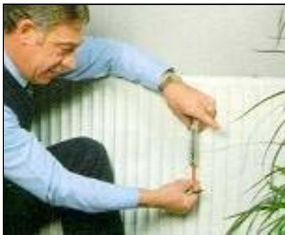
Si les circuits ne correspondent pas aux surfaces attribuées aux différents occupants, on peut placer des compteurs individuels (appelé calorimètres) sur les radiateurs
